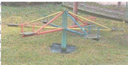
nárazu z iných zariadení sa neprekryvajú. Stredový stĺp je uchytený v zemi, ošetrený proti záchyteniu, kolotoč má konštrukciu, kde nevytrčajú prvky za jej okraj. V priestore pádu nie sú žiadne prekážky. Na sedenie je použitý drevený materiál, ktorý nevykazuje známky materiálového opotrebovania. Na zariadení neboli nájdené materiálové nedostatky a závady, ktoré by ohrozovali bezpečnosť užívateľov.
